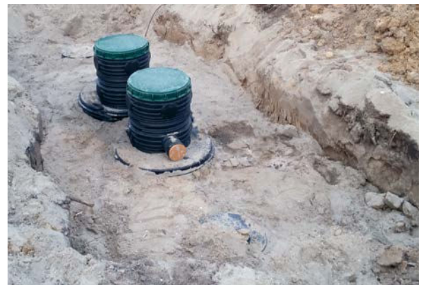
Rysunek 2. Oczyszczalnia actibio podczas montażu.
